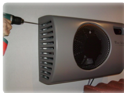
Montera kåpan på Winemaster dra åt de 4 skruvarna.
